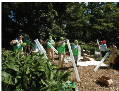
保護管組立ての様子
